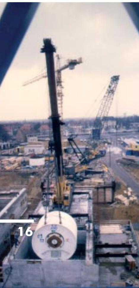
**Die Schildvortriebsmaschine HERAKLES wird in die HERA-Halle Süd hinuntergelassen.**
