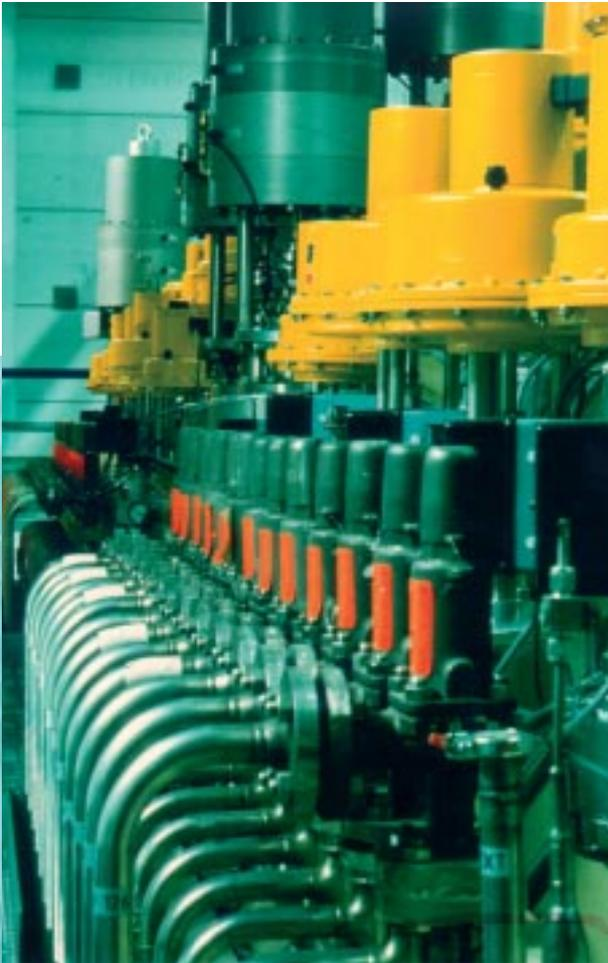
**Ein ausgeklügeltes Ventilsystem verteilt das flüssige Helium an die supraleitenden Magnete des HERA-Rings.**
