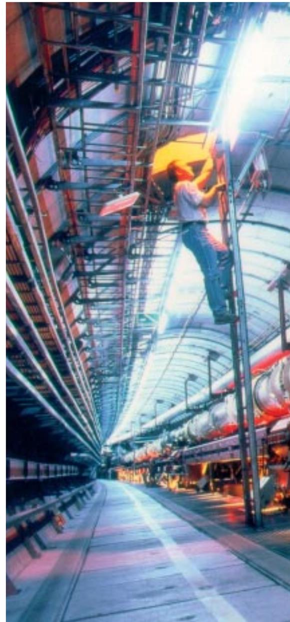
**Blick in den HERA-Tunnel: Unterhalb des Protonenbeschleunigers mit seinen supraleitenden Magneten (beige) verlaufen die normalleitenden Magnete des Elektronenrings.**
