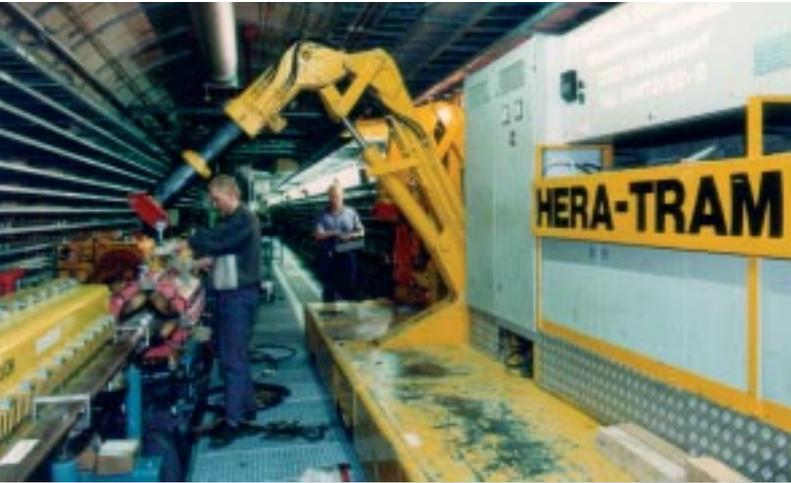
**Die tonnenschweren neuen Magnete werden mit Hilfe der „HERA-Tram“ im Tunnel transportiert und aufgestellt.**
