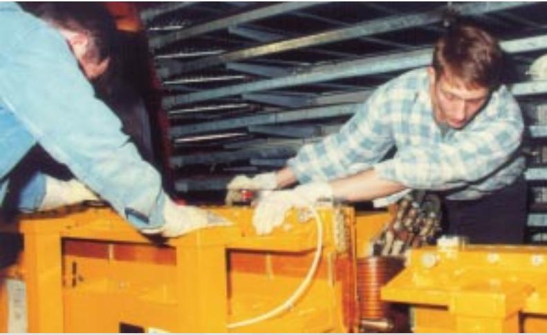
**Das Aufstellen der schweren Magneten ist Präzisionsarbeit. Auf wenige zehntel Millimeter genau muss hier alles zueinander passen.**
